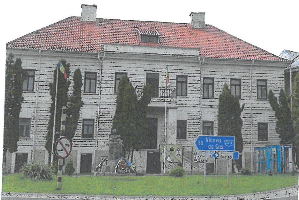
Clădirea fostei primării a orașului Siret
